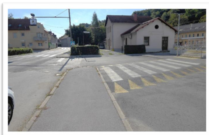
Prehod za pešce na zelo prometnem delu cestišča (levo)
