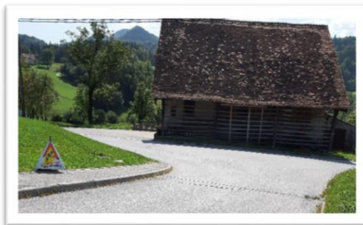
Nevaren odsek brez površin za pešce
