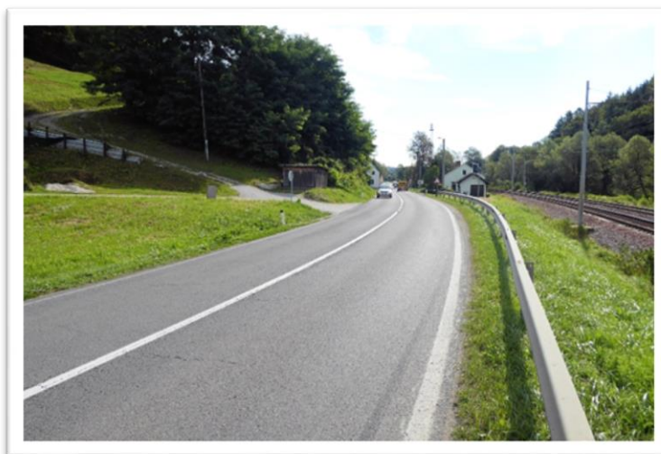
Nevaren odsek brez površin za pešce pri zaselku Loke
