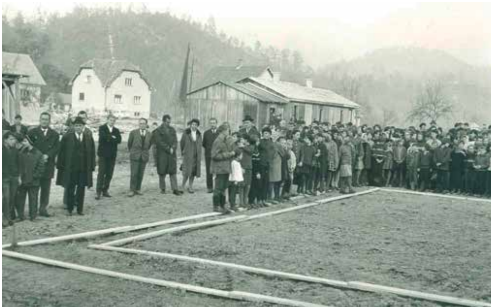
Slovesnost ob pričetku gradbenih del septembra 1965.
